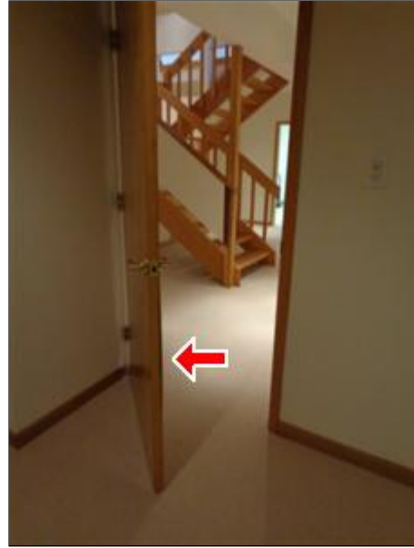
4.5 Picture 4 door de-laminating
