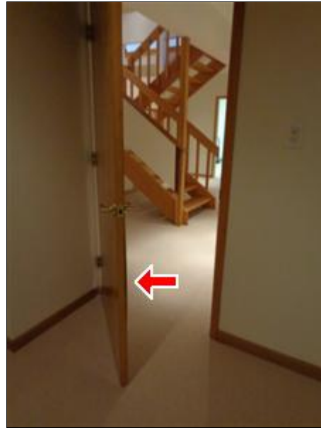
4.5 Picture 4 door de-laminating
